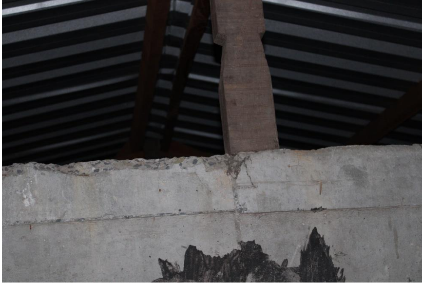
Figura 88 – Vista interna telhado e vigamento
