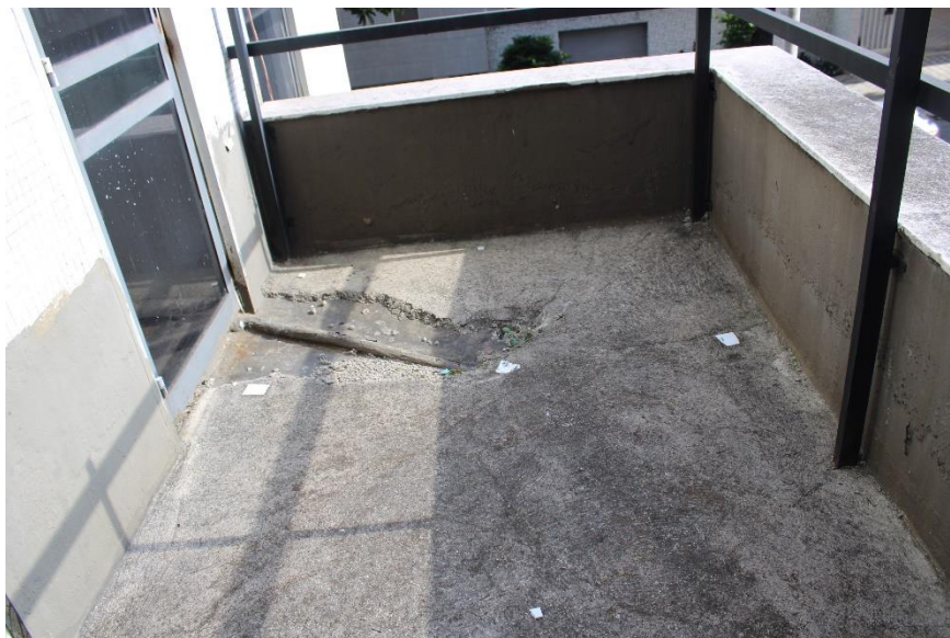
Figura 214 – Tubulação passando sob o piso – área externa 3º pavimento
