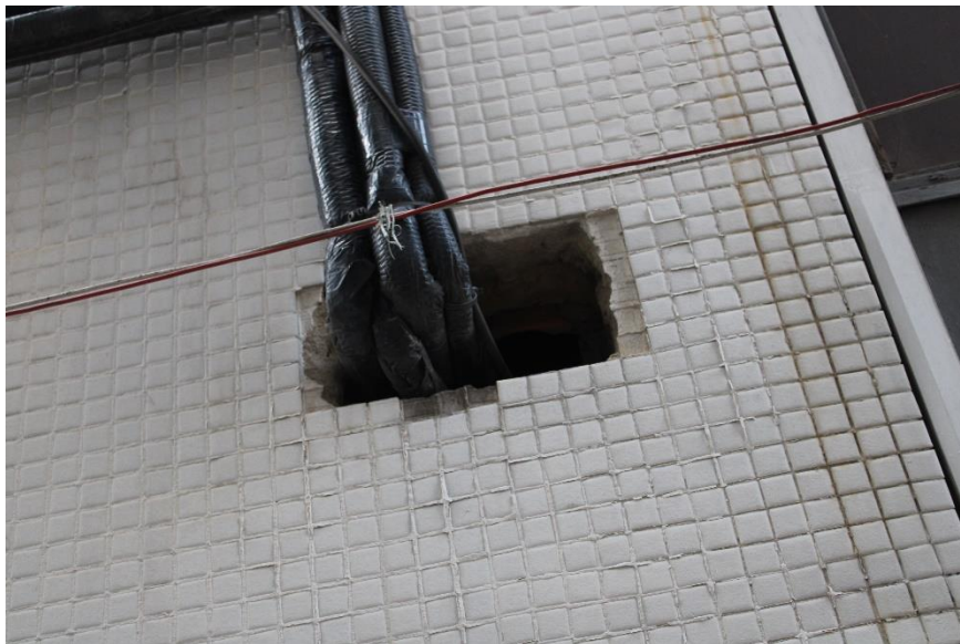
Figura 212 – Vista abertura na fachada – área externa 3º pavimento
