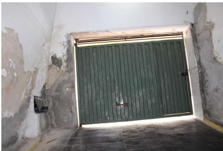
Figura 338 – Vista interna acesso à garagem
