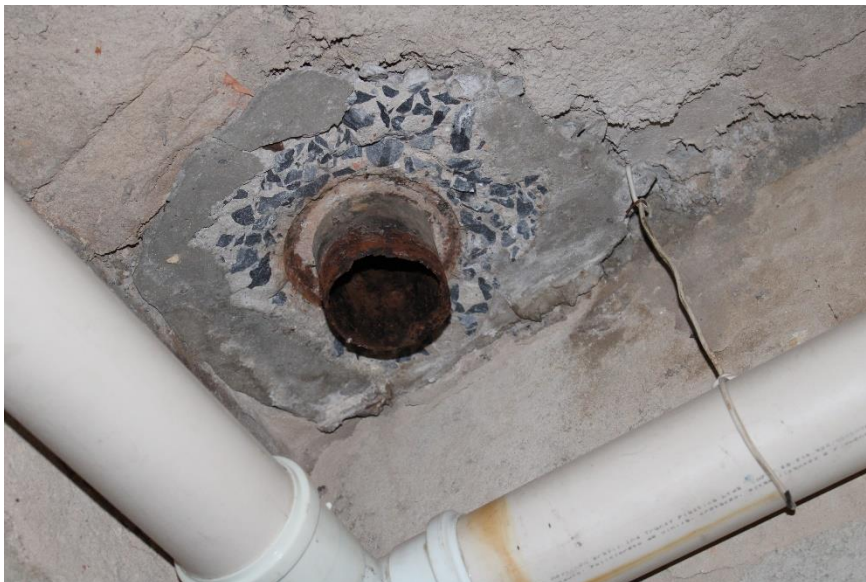
Figura 123 – Vista tubulação de ferro, aparentemente desativada
