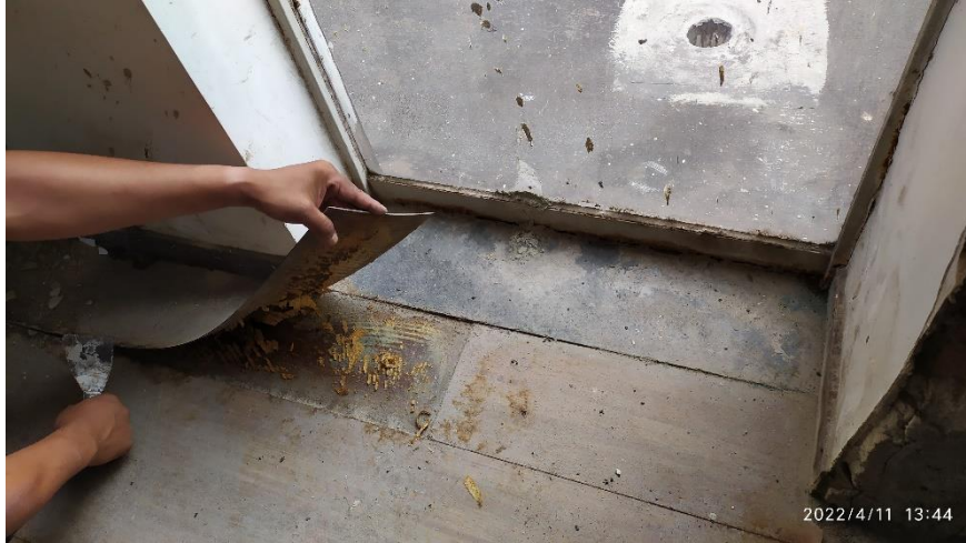
Figura 60 - Vista parcial piso - 6º pavimento
