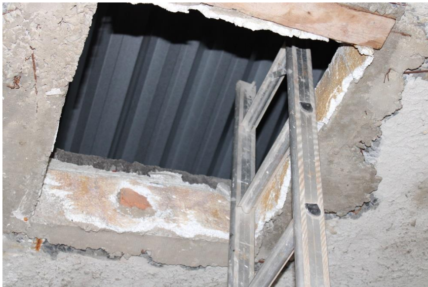
Figura 47 – Vista acesso ao telhado – 6º pavimento
