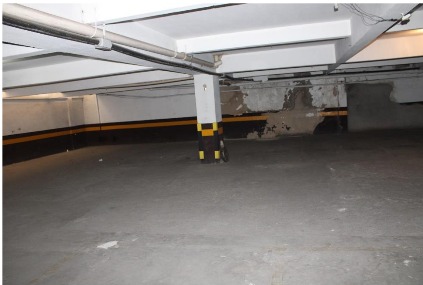
Figura 306 – Vista parcial garagem
