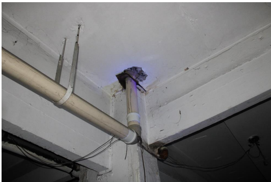
Figura 326 – Vista furo na laje para passagem de tubulação – garagem
