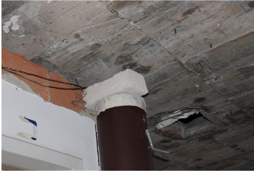
Figura 44 – Vista estrutura que aparentemente foi construído depois – 6º pavimento
