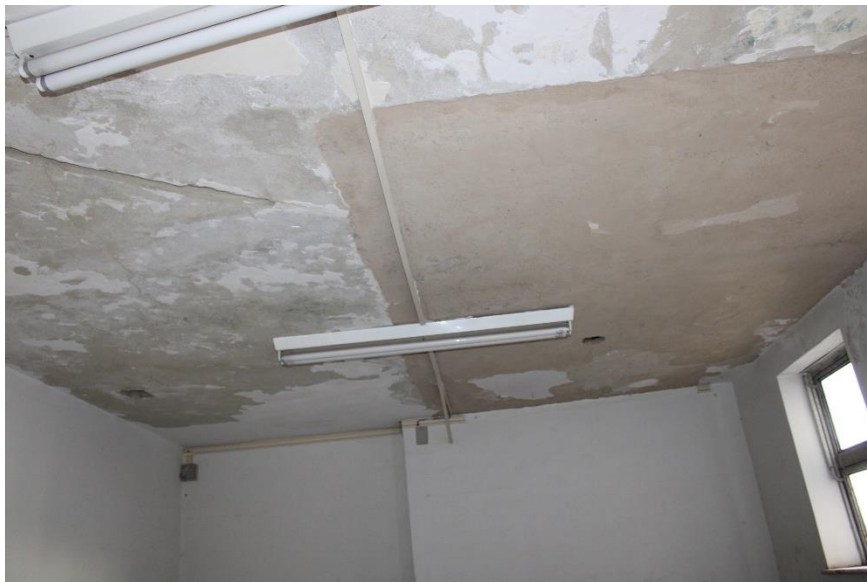
Figura 28 – Vista teto sala – 6º pavimento
