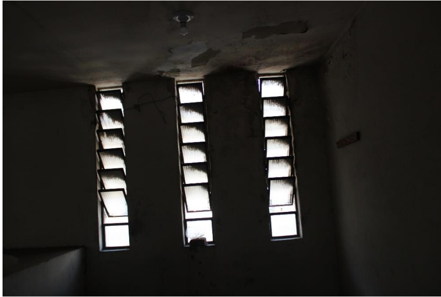
Figura 110 – Descascamento de pintura e manchas de umidade na parede
