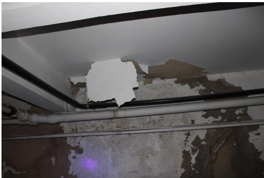
Figura 312 – Vista parcial parede e teto - garagem
