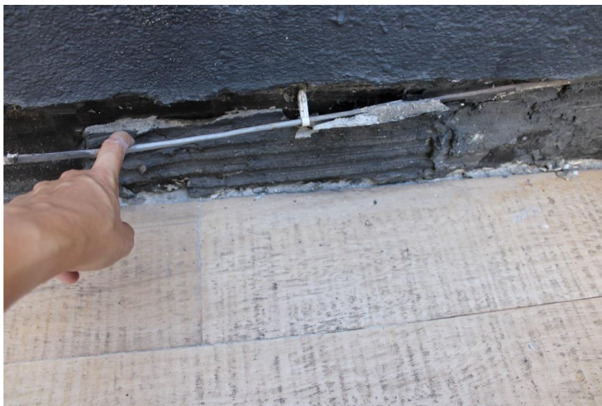
Figura 257 – Vista parcial base do guarda-corpo – área externa fundos
