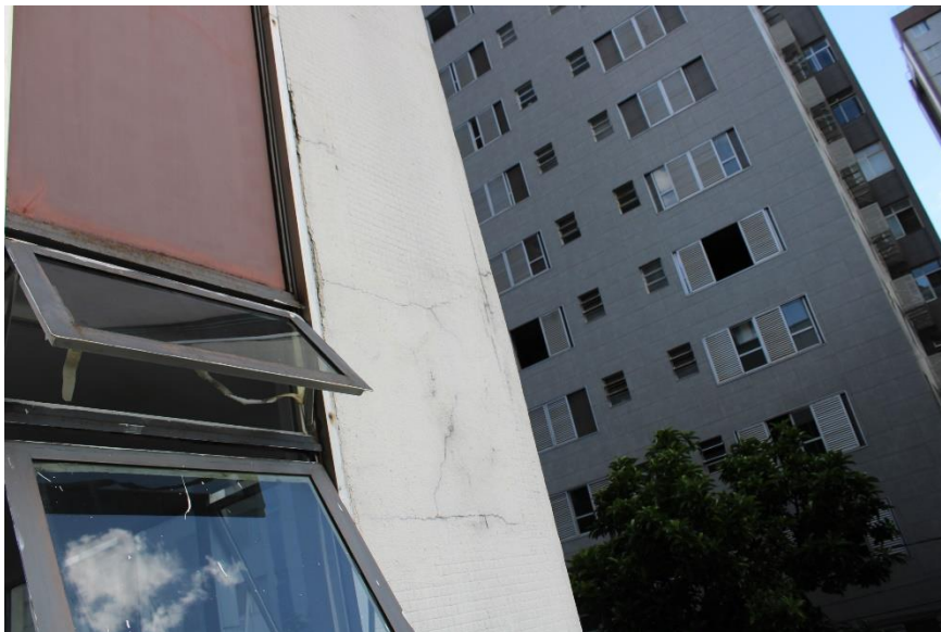
Figura 222 – Vista parcial fachada lateral direita
