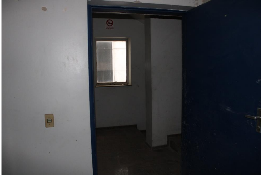
Figura 148 – Vista parcial caixa de escada – 5º pavimento – mezanino
