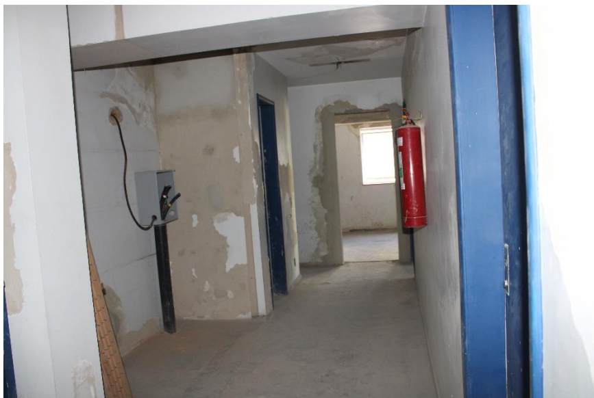
Figura 147 - Vista parcial hall – 5º pavimento – mezanino
