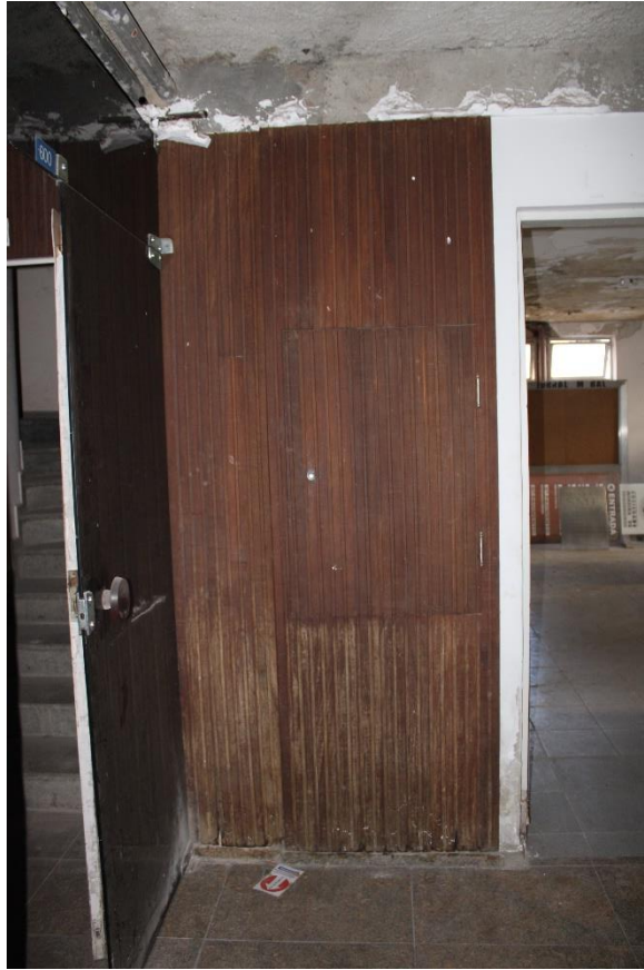
Figura 40 – Vista fechamento de madeira – hall 6º pavimento
