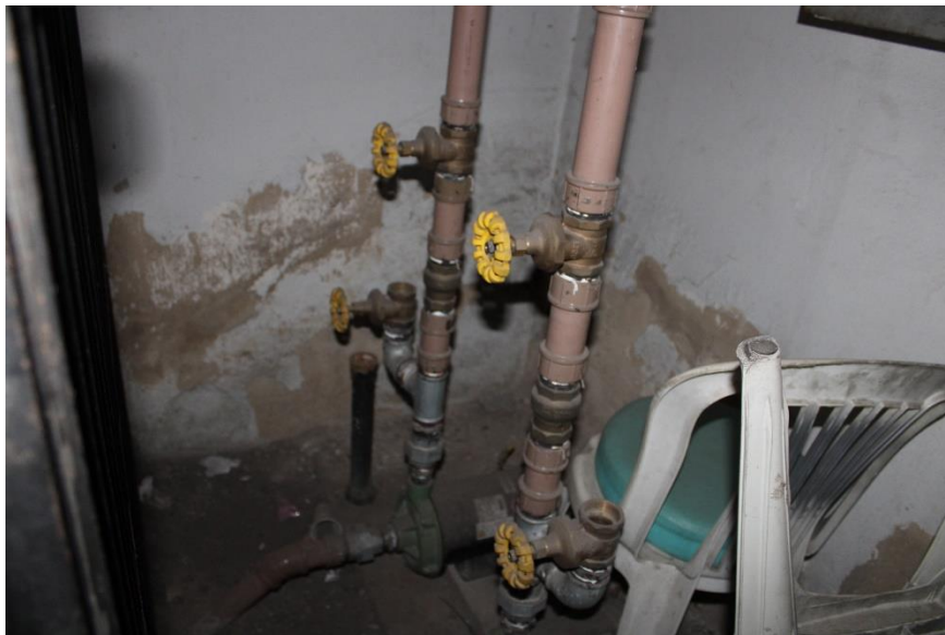
Figura 304 – Descascamento de pintura na base da parede – garagem
