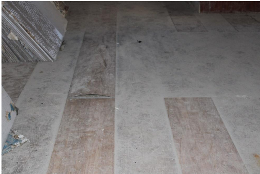
Figura 55 – Vista piso 6º pavimento
