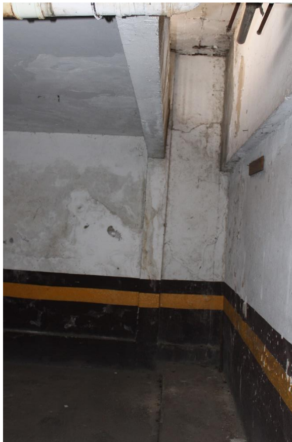
Figura 288 – Vista parcial parede - garagem
