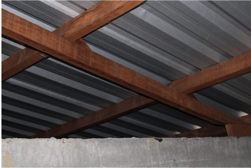
Figura 92 – Vista madeiramento telhado e parede
