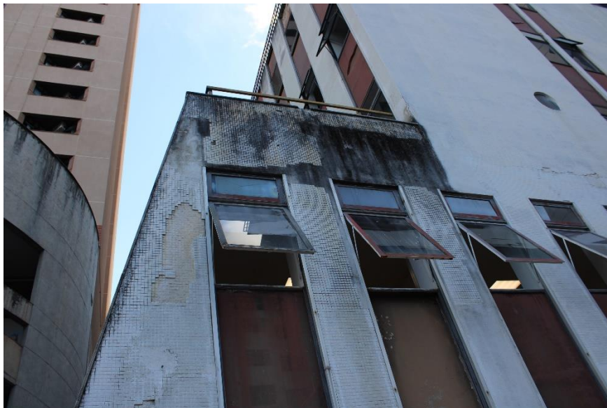
Figura 251 – Vista parcial fachada fundos
