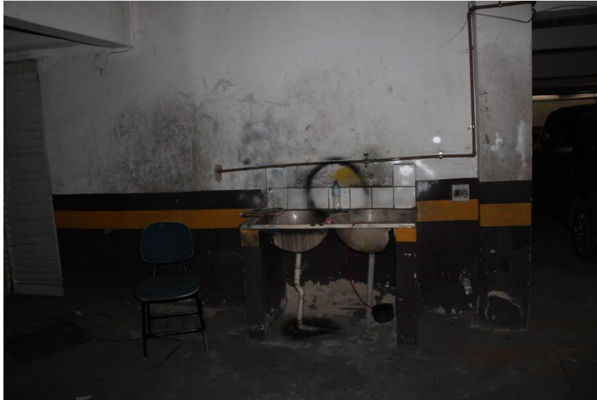
Figura 317 - Vista parcial garagem
