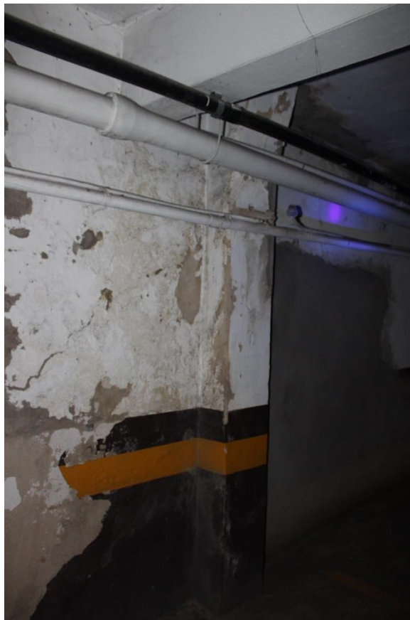
Figura 314 - Vista parcial parede - garagem
