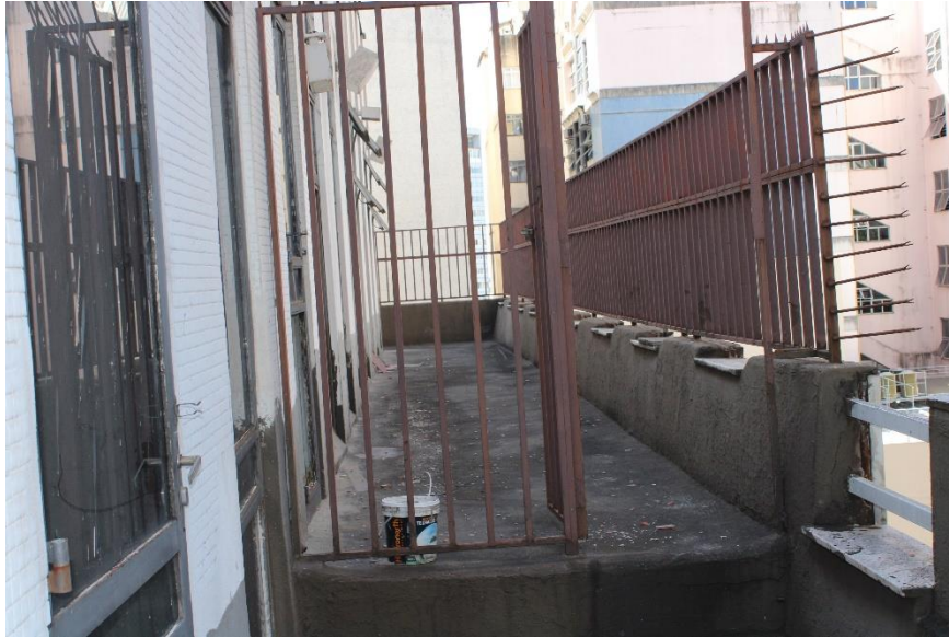
Figura 3 – Vista parcial área externa 6º pavimento
