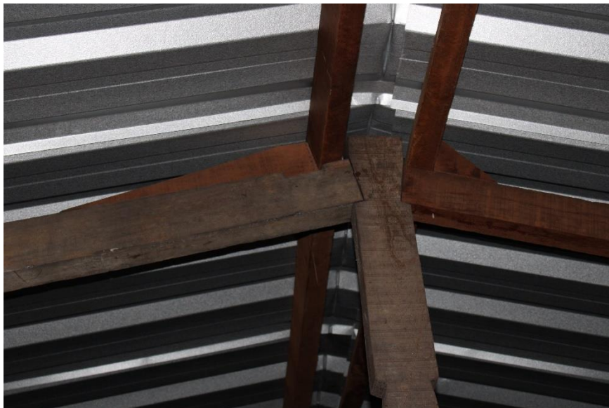
Figura 87 – Vista telhado e vigamento
