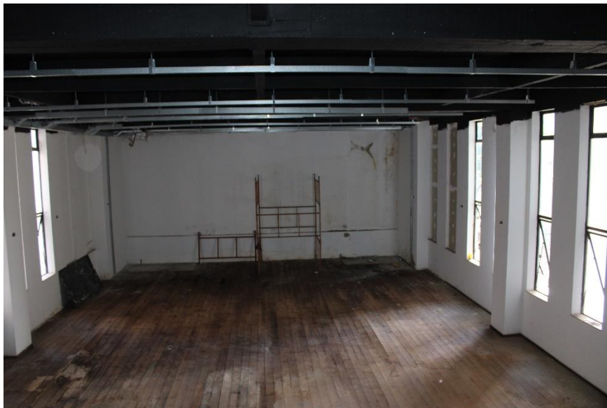
Figura 157 – Vista salão 4º pavimento
