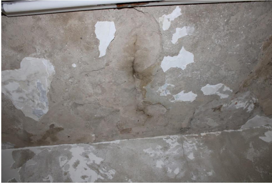
Figura 35 – Detalhe laje e parede – sala 6º pavimento (arquivo)
