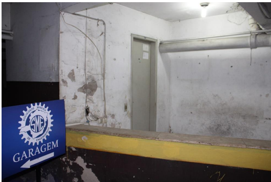
Figura 316 – Vista parcial garagem
