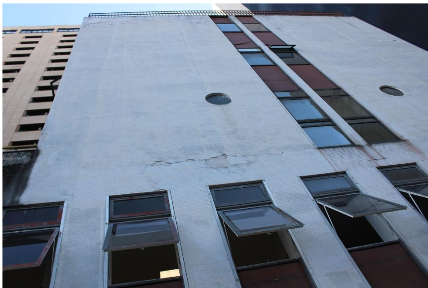
Figura 253 – Vista parcial fachada fundos
