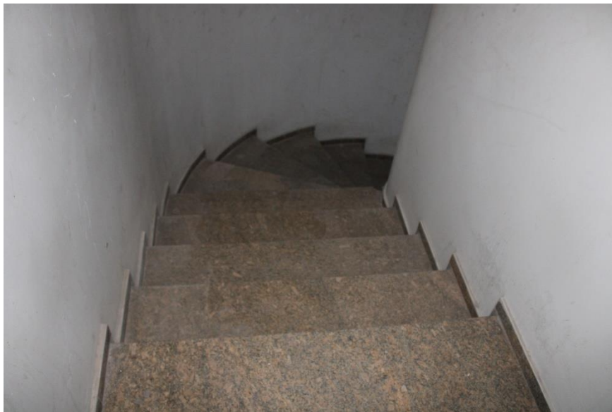
Figura 99 – Vista escada de acesso ao 5º pavimento
