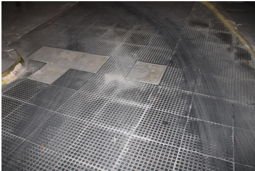
Figura 339 – Vista piso rampa
