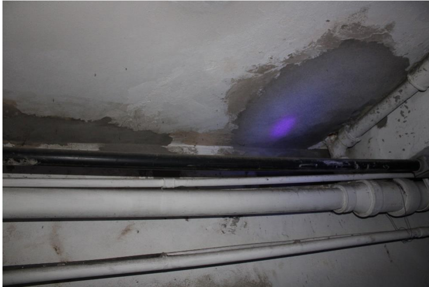
Figura 315 – Vista reparos no teto – garagem
