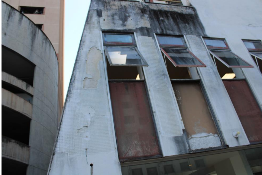
Figura 252 – Vista parcial fachada fundos
