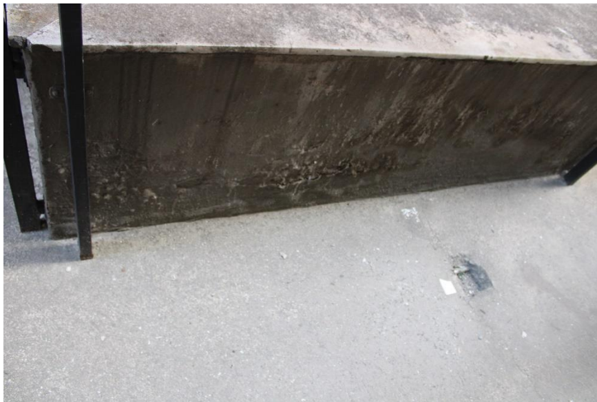
Figura 198 – Vista manta no guarda-corpo – área externa 3º pavimento
