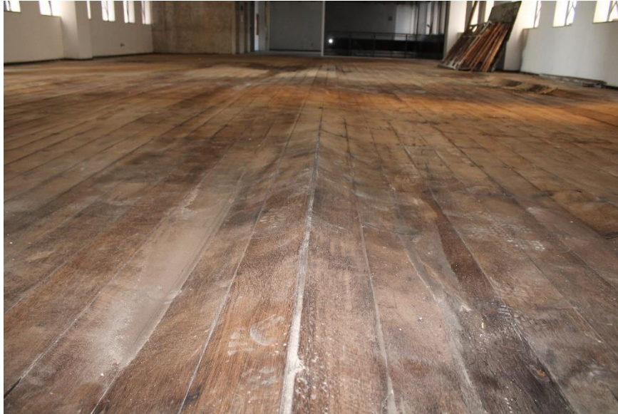
Figura 158 – Vista piso estufado - 4º pavimento
