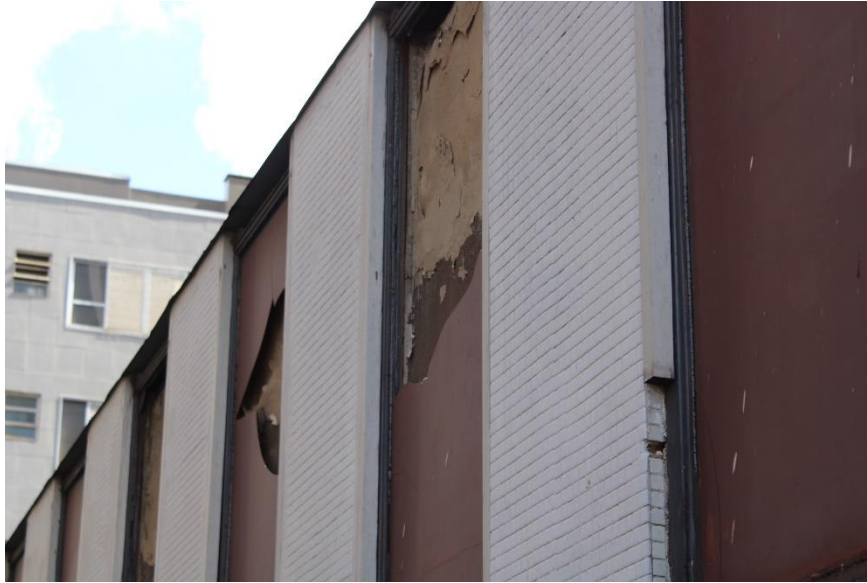
Figura 5 – Vista parcial fachada lateral esquerda
