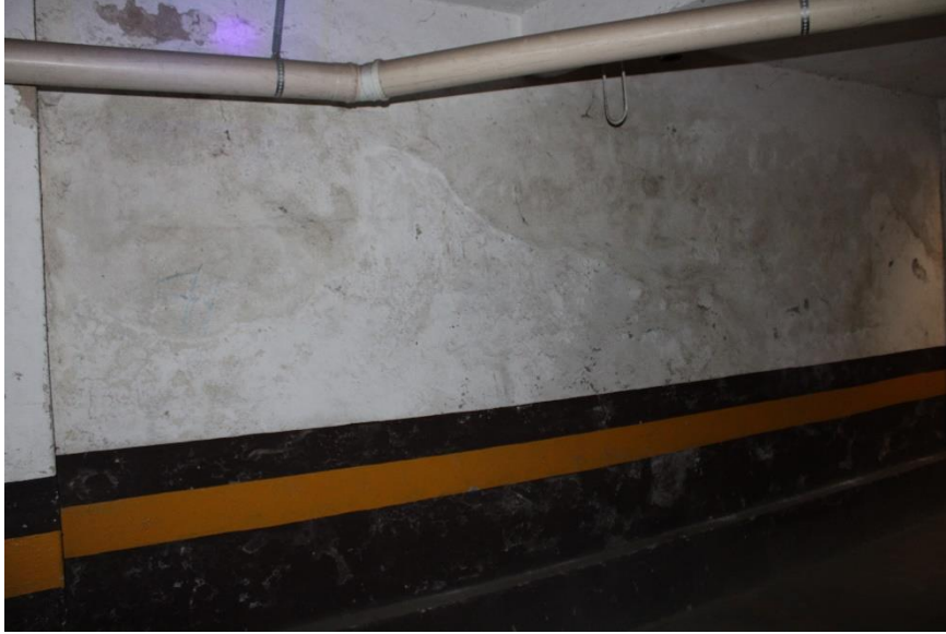
Figura 301 – Vista parcial parede – garagem
