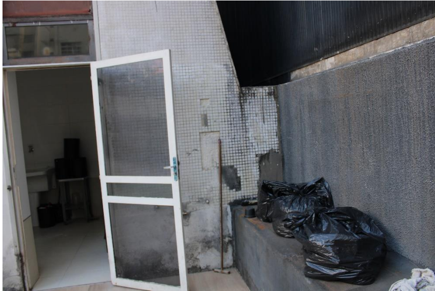
Figura 254 – Vista parcial fachada fundos
