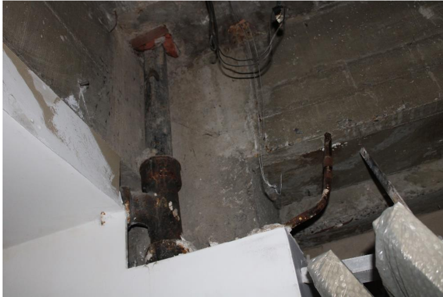
Figura 285 - Vista parcial mezanino
