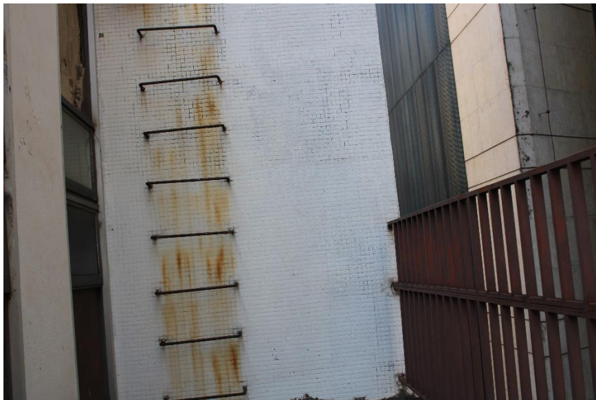
Figura 26 – Vista escada marinheiro de acesso ao telhado
