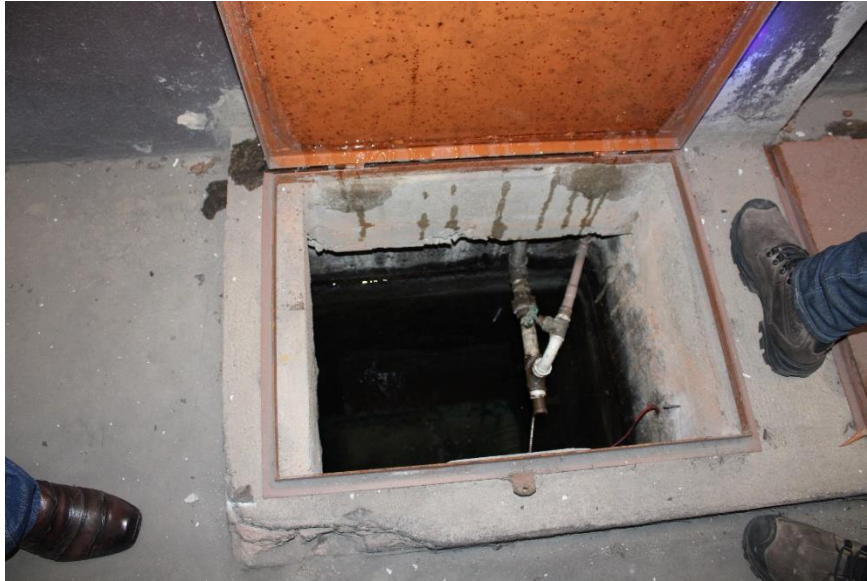
Figura 307 – Vista acesso do reservatório inferior – garagem
