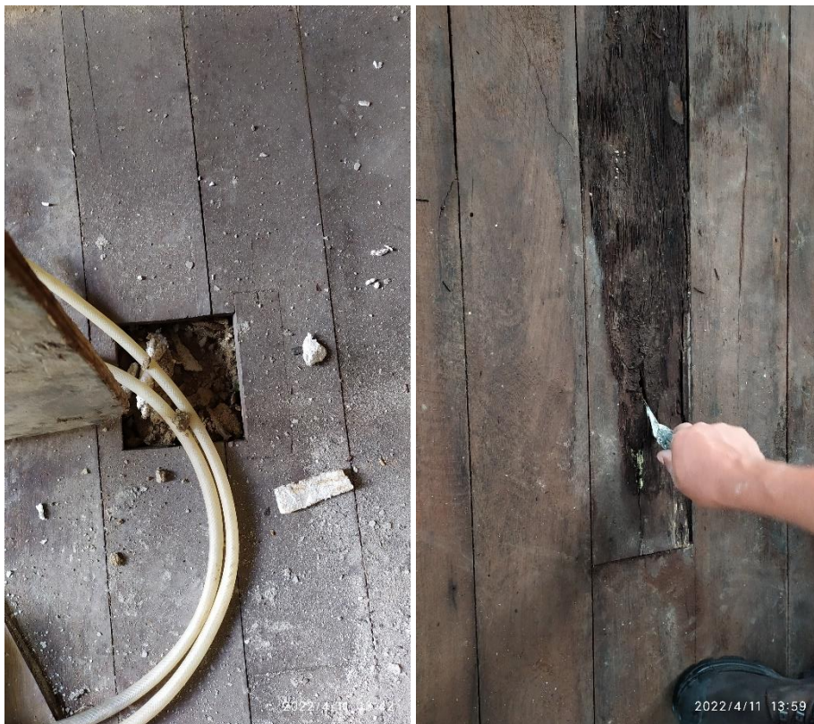
Figura 59 – Vista parcial piso - 6º pavimento
