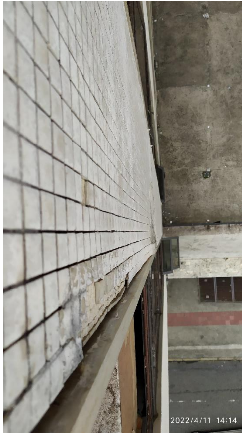
Figura 70 – Vista parcial fachada e estrutura metálica de suporte dos vidros
