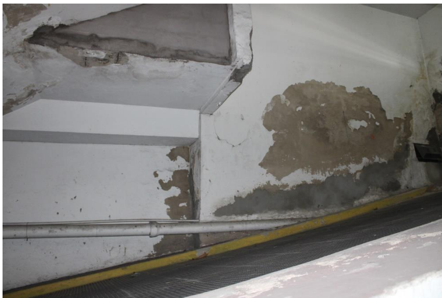
Figura 332 – Vista parede da rampa de acesso – garagem
