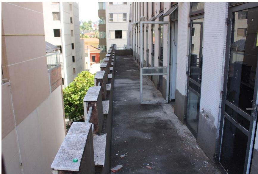
Figura 4 - Vista parcial área externa 6º pavimento
