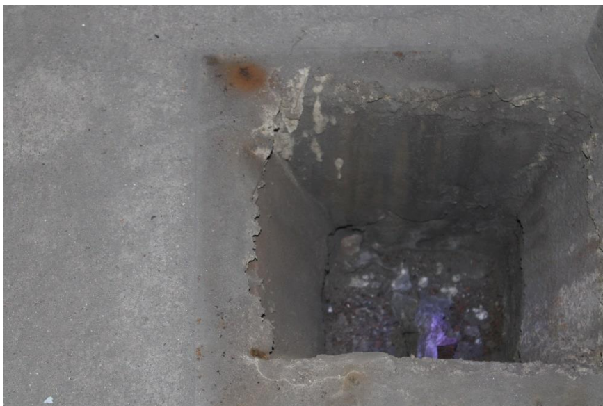
Figura 310 – Vista caixa pluvial
