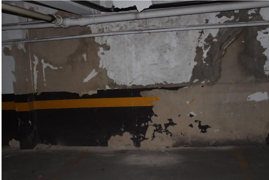
Figura 287 – Vista parcial parede - garagem
