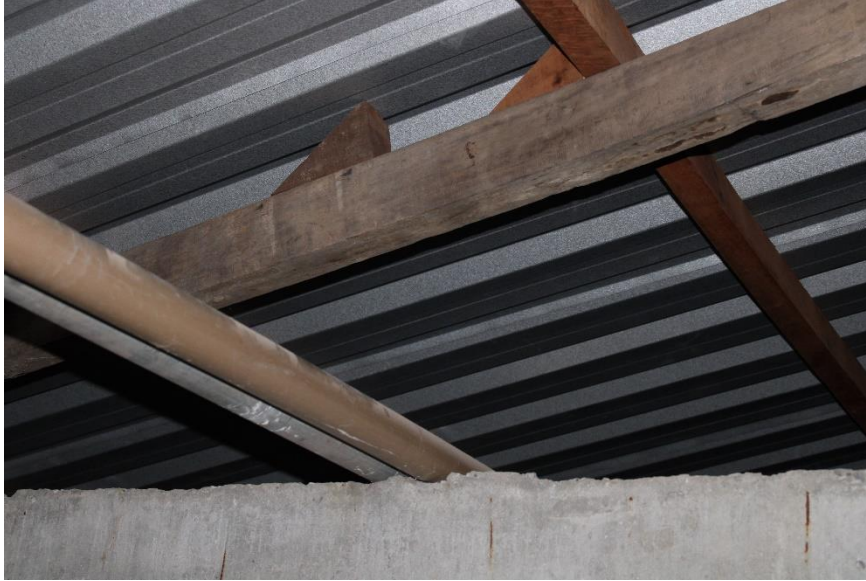
Figura 90 – Vista tubulação apoiada na viga
