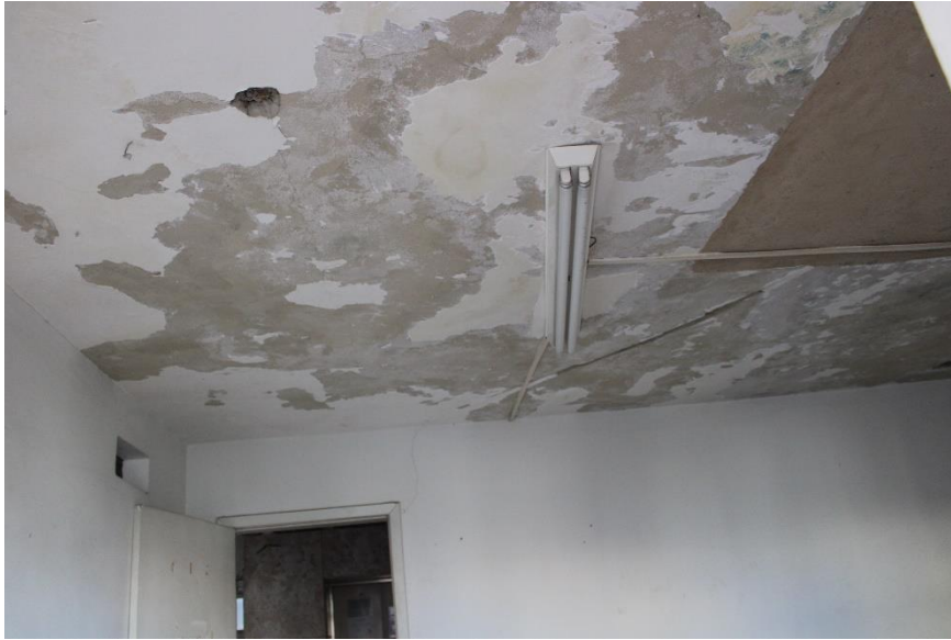
Figura 29 – Vista teto sala – 6º pavimento
