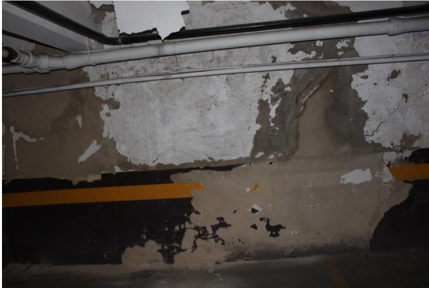
Figura 313 - Vista parcial parede e teto - garagem
