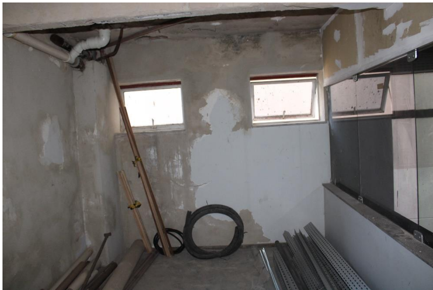
Figura 131 – Vista parcial parede – 5º pavimento – mezanino
