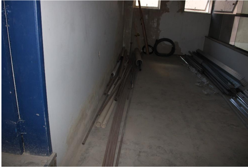
Figura 130 – Vista parcial piso e parede – 5º pavimento – mezanino
