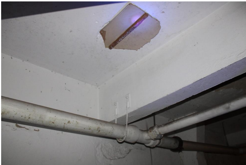
Figura 302 – Vista parcial teto e tubulações – garagem
