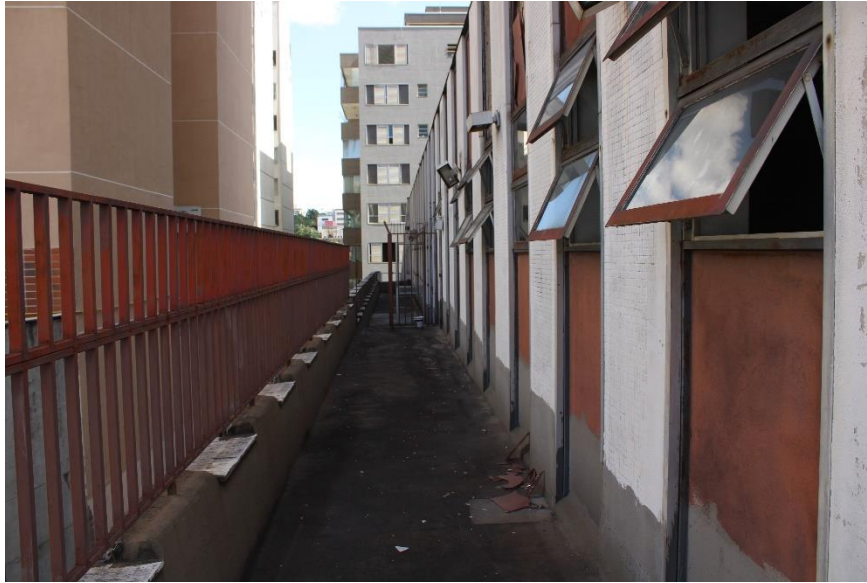
Figura 11 – Vista impermeabilização na base da parede – fachada lateral esquerda
