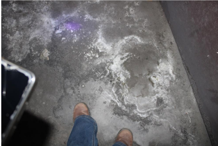
Figura 329 – Vista parcial piso – garagem
