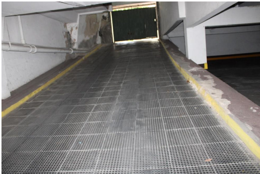
Figura 334 – Vista rampa garagem
