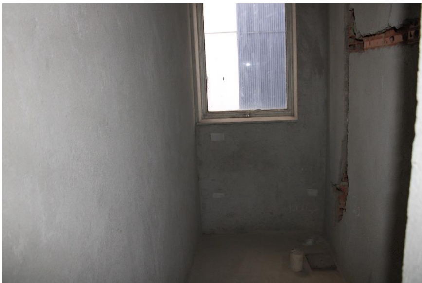
Figura 145 – Vista parcial banheiro inacabado
