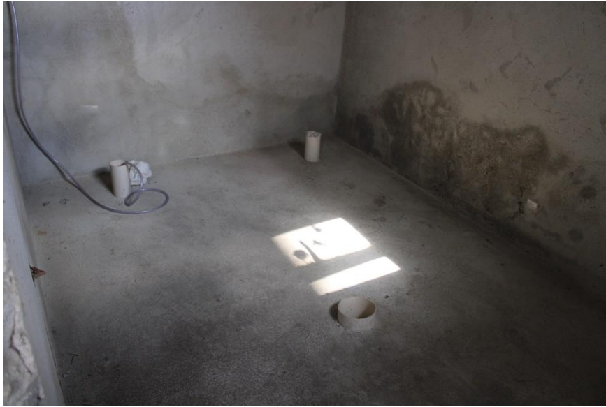
Figura 64 – Vista piso cômodo
