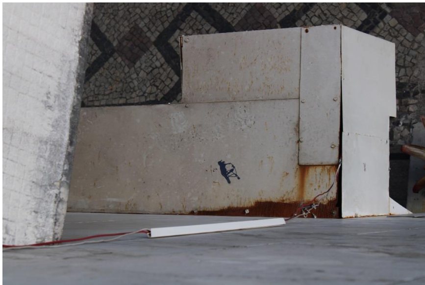
Figura 220 – Vista superior da marquise
