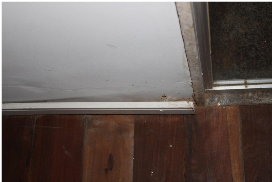
Figura 224 – Vista base da parede – 2º pavimento
