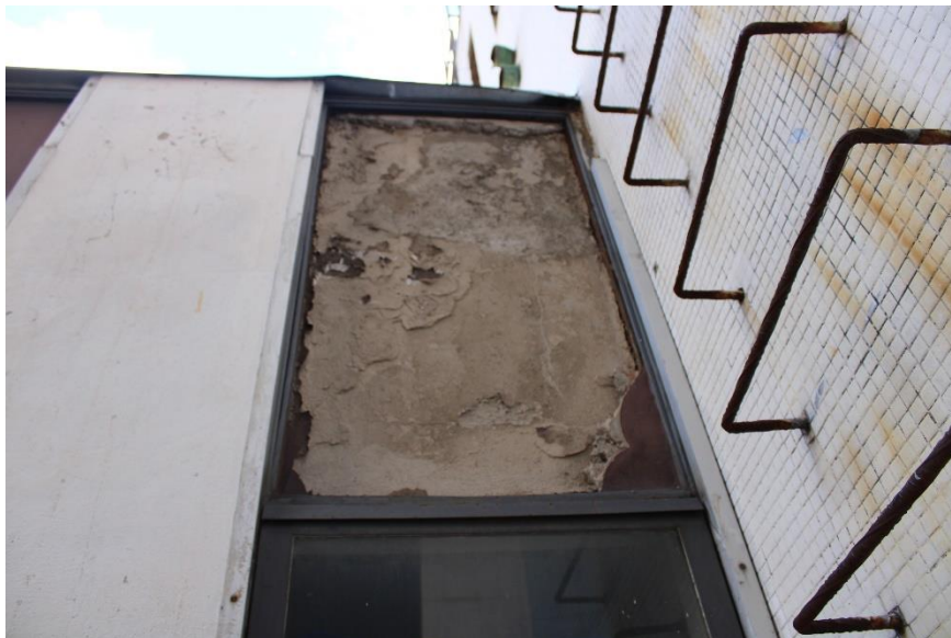
Figura 24 - Vista parcial fechamento fachada – fachada lateral direita
