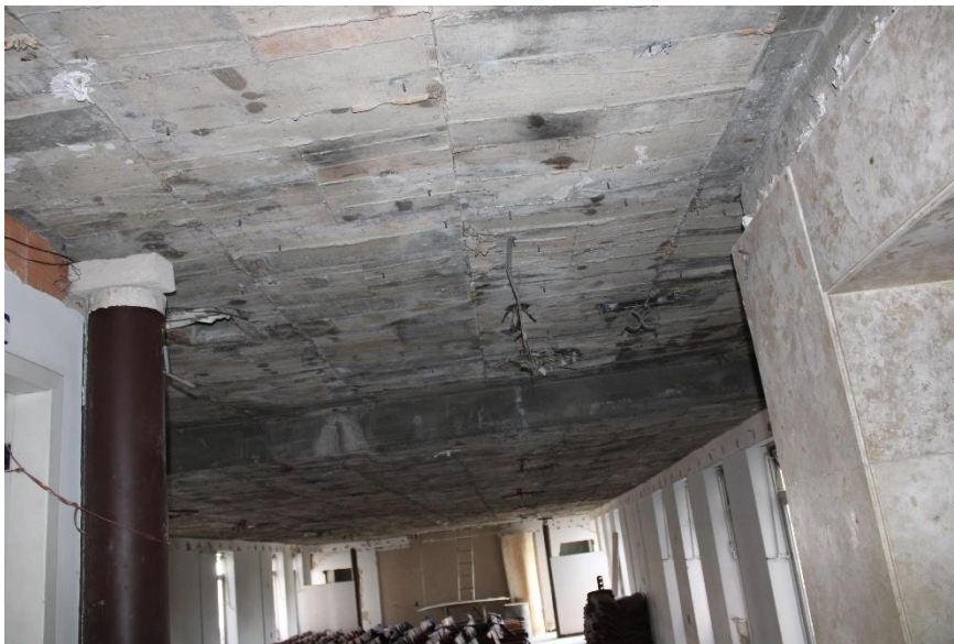
Figura 43 – Vista parcial teto – 6º pavimento
