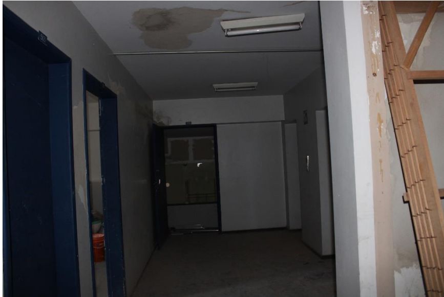
Figura 146 – Vista parcial hall – 5º pavimento – mezanino
