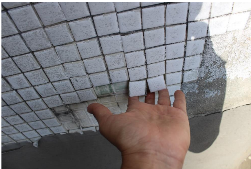
Figura 83 – Deslocamento de pastilhas fachadas
