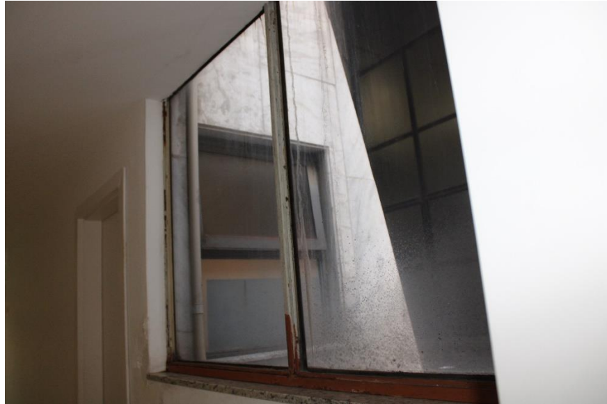
Figura 244 – Vista estrutura metálica da janela – 1º pavimento
