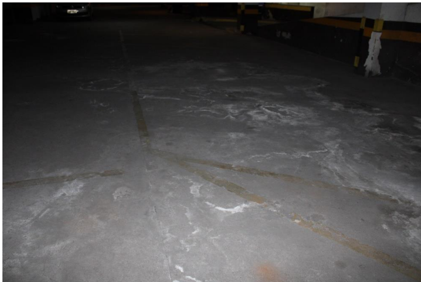
Figura 328 – Vista parcial piso garagem
