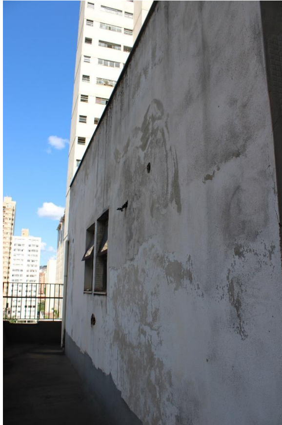
Figura 13 – Vista parcial fachada fundos
