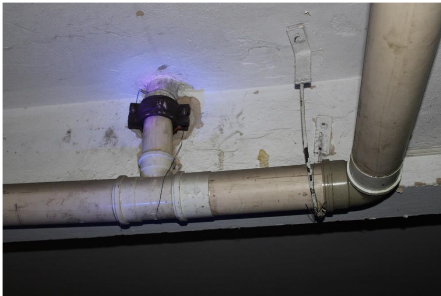
Figura 298 – Vista parcial tubulações – garagem
