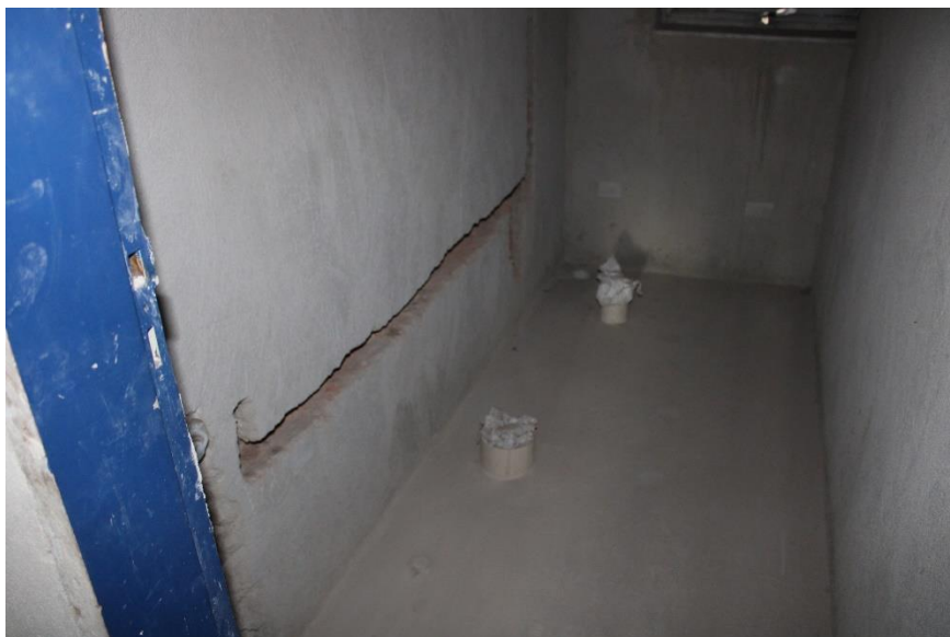
Figura 143 – Vista banheiro inacabado – 5º pavimento – mezanino
