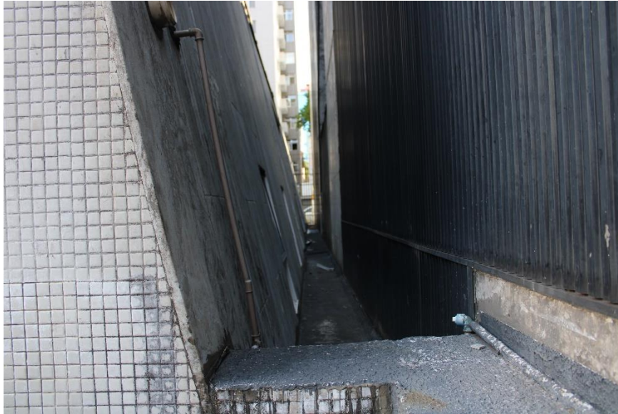
Figura 256 – Vista parcial fachada lateral direita
