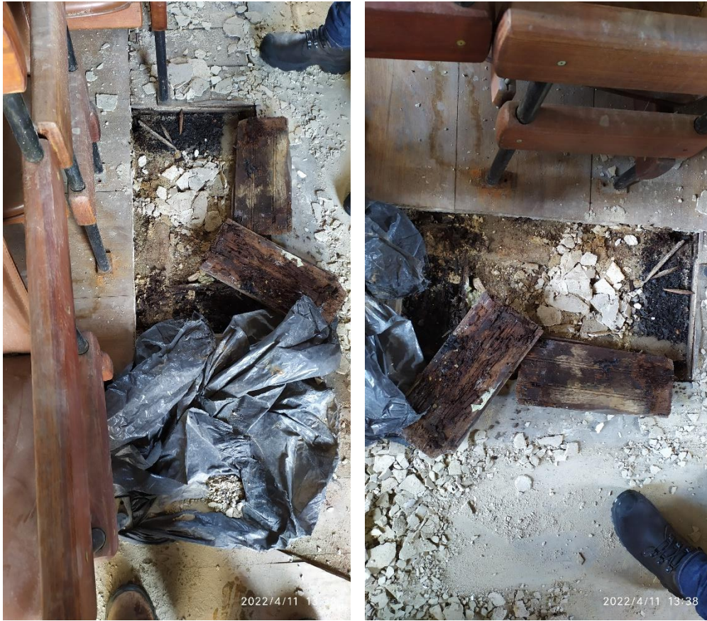
Figura 56 – Vista piso 6º pavimento
