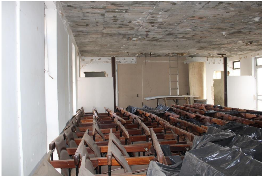
Figura 85 – Vista parcial interna auditório – 6º pavto
