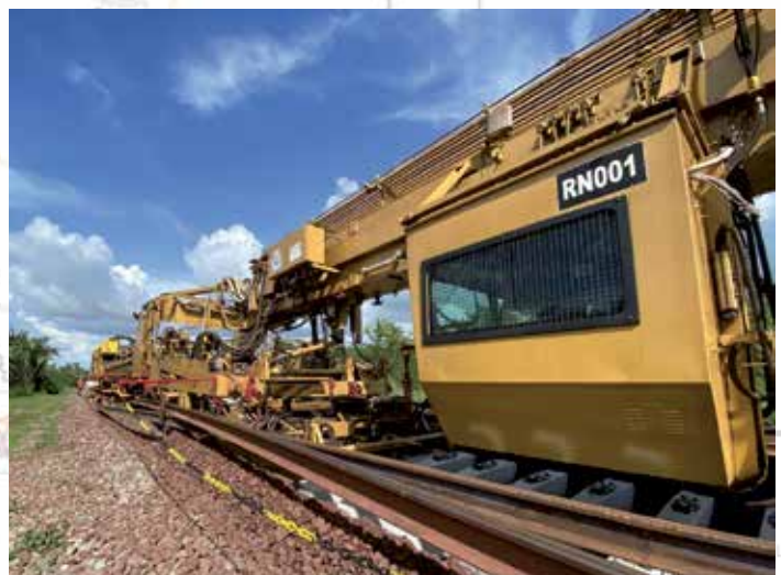
Renovação da Estrada de Ferro de Carajás
