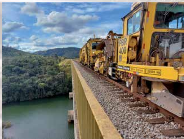
Conjunto de Socadora e Reguladora trabalhando na correção geométrica da Estrada de Ferro Vitória-Minas.
